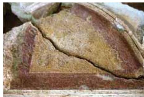
Presencia de sulfatos en forma de fibras.
