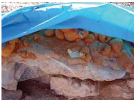
Detalle del techo donde se observa la malla de fibra de vidrio y la espuma.
