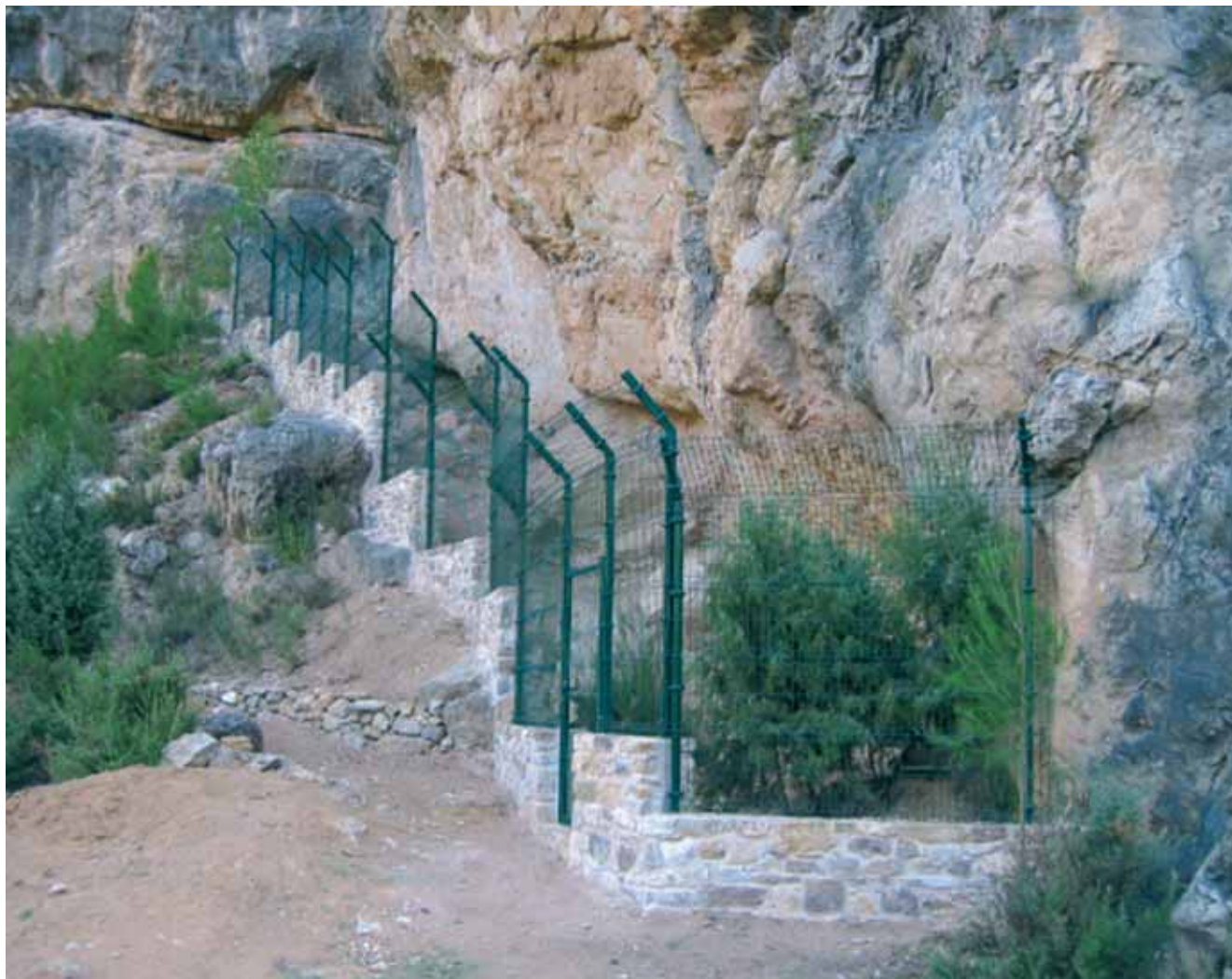
Fig. 9. Vista desde el exterior del abrigo con su protección concluida
