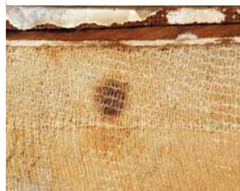
Manchas de óxido de los clavos que sujetan el táblex al bastidor. Se aprecia la colocación del táblex con la cara rugosa hacia el anverso para favorecer el agarre de la preparación.
