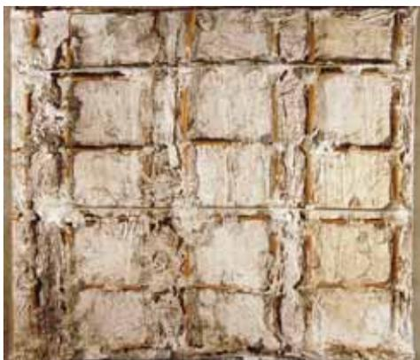
Reverso de yeso formado por tres placas con sus cañas. Se aprecian dos varillas usadas en el arranque.
