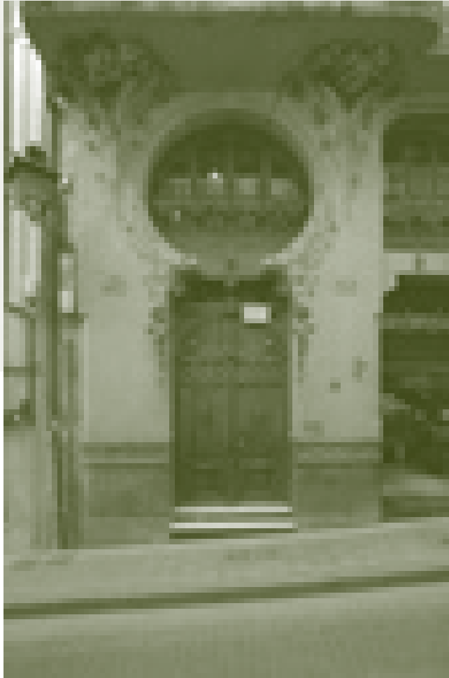
Detalle de la Arquitectura Modernista en Teruel
