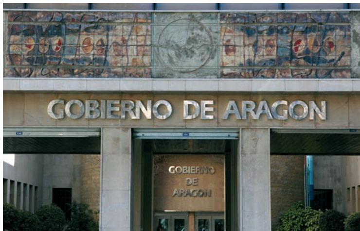
Edificio administrativo del Gobierno de Aragón en la plaza de San Pedro Nolasco, Zaragoza.
