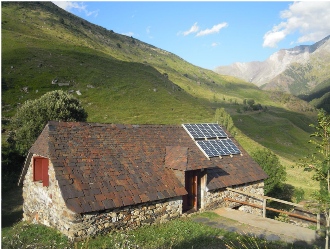
Energía solar fotovoltaica en el Refugio de Biadós (Huesca)
