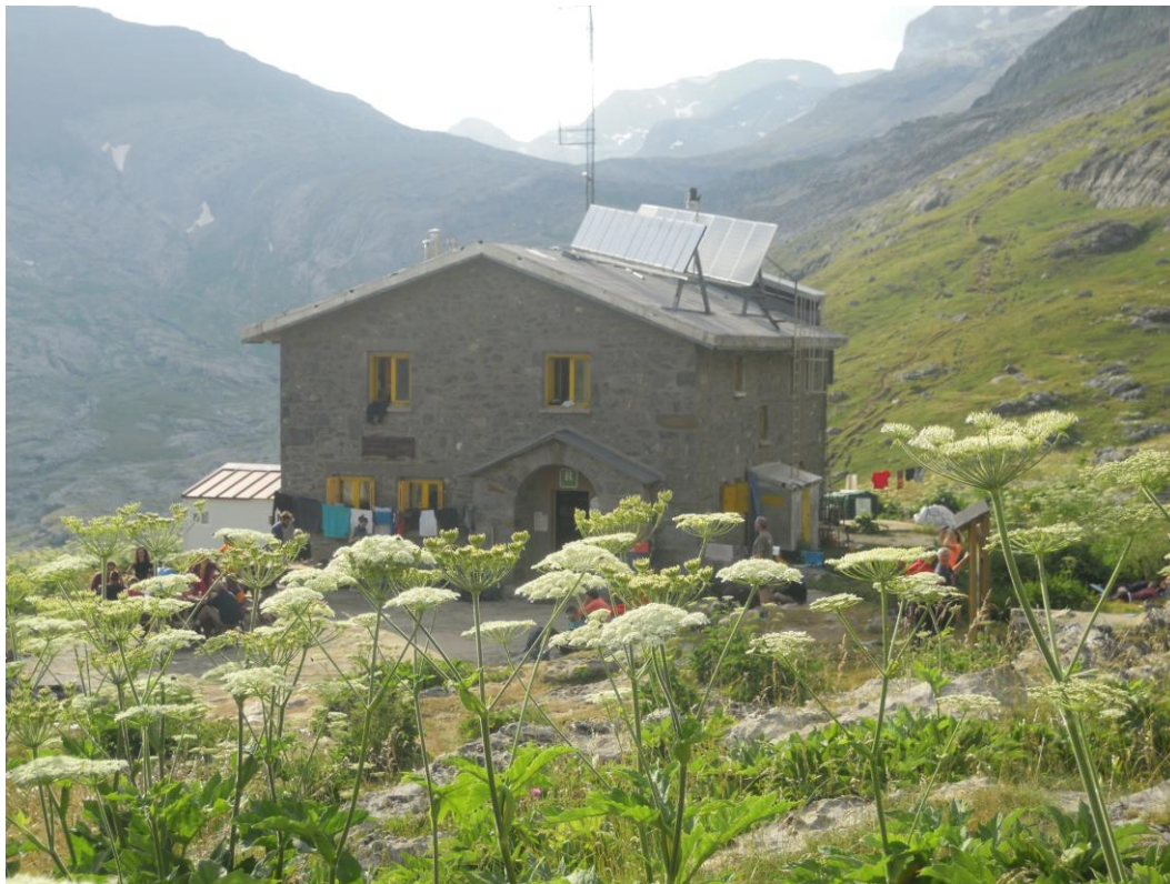
Instalación solar fotovoltaica en el renovado Refugio de Góriz (Parque Nacional de Ordesa, Huesca)
