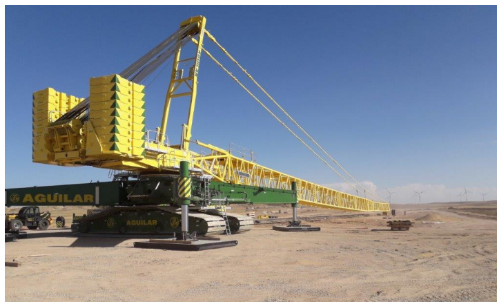
Montaje de la grúa para aerogeneradores en el Parque eólico "El llano" de 49,95 MW (Zaragoza)
