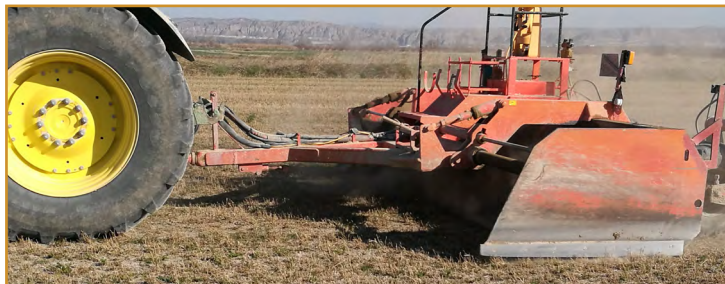
Pase de niveladora
