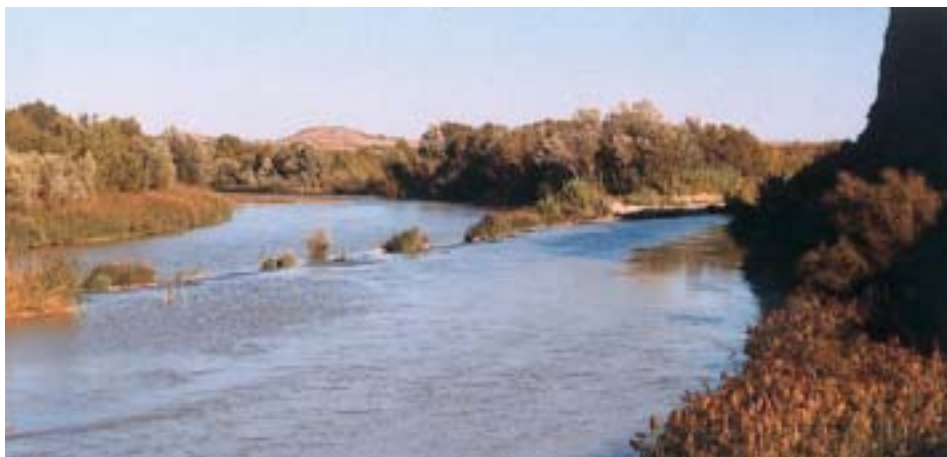
Azud en el Cinca (término de Ballobar) para las dos acequias de Velilla, Fraga y Torrente, llamadas de Dalt y de Baix
