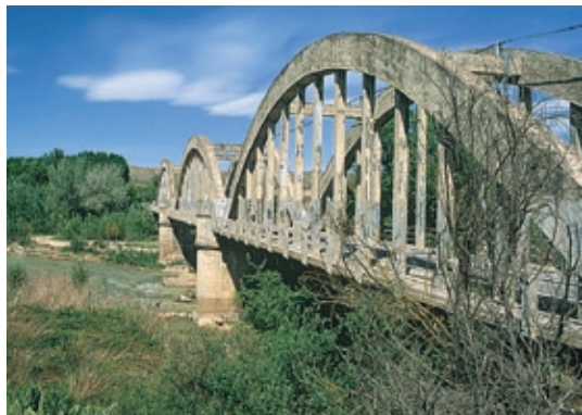
Puente sobre el Alcanadre en Ontiñena
