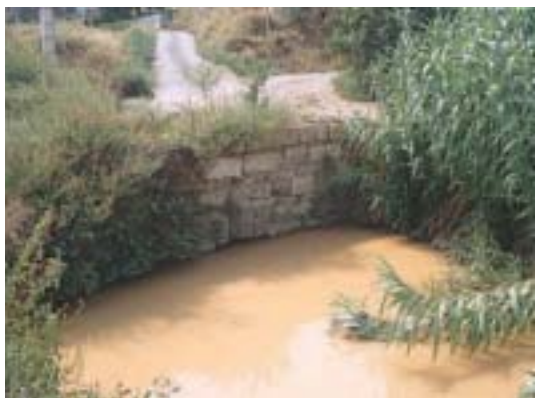
Huerta de Fraga. Puente al servicio del antiguo Camino Real sobre la Acequia Nueva
