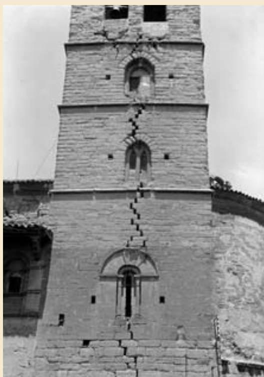
Torre (antes de la restauración)
