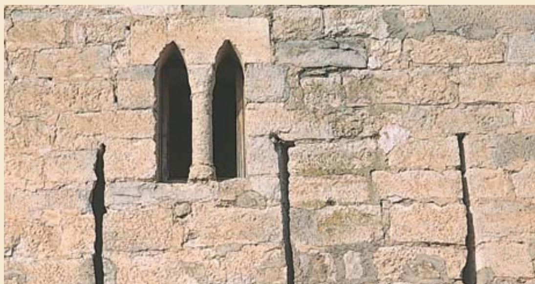
«Torre de los Frailes». Ventanal y aspilleras
