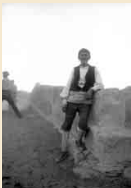
Ballobar. En el estribo del puente
