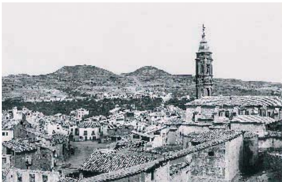
Vista antigua de Alcorisa, con la iglesia en un extremo de la población
