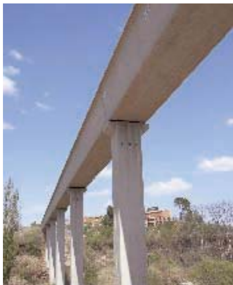
Canalización de hormigón para regadíos
