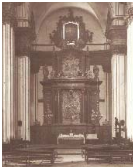
Alcañiz. Antigua postal que muestra el retablo mayor de la iglesia de Santa María la Mayor antes de su transformación
