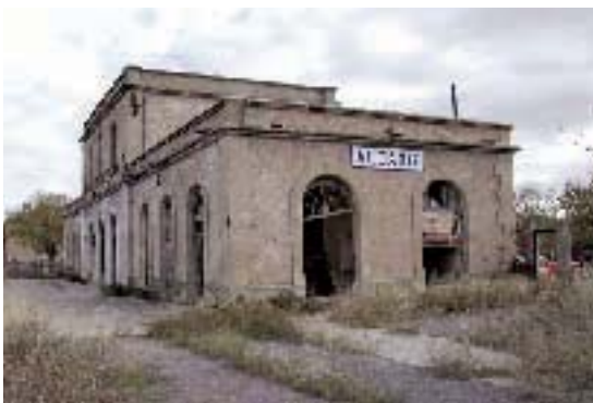
Estación de Alcañiz. La recuperación del tren es un reto para el futuro
