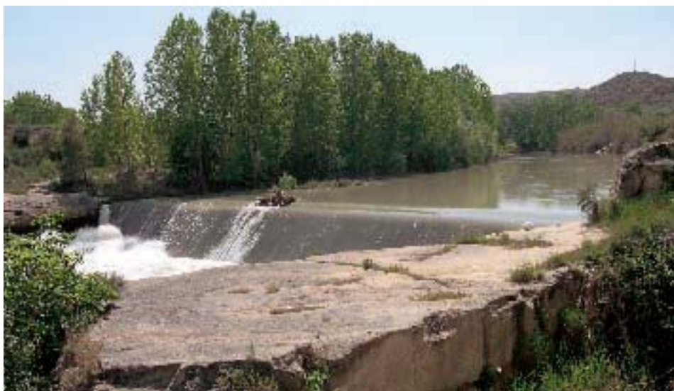
Vista de uno de los azudes del Guadalupe, en el entorno de Alcañiz
