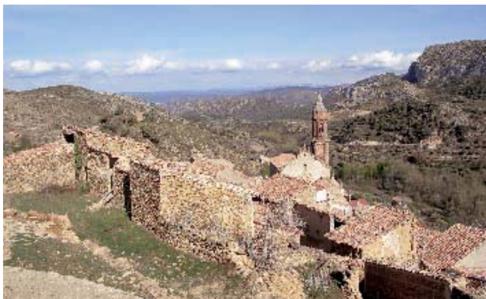
Arquitectura y paisaje se funden en el pequeño caserío de Seno.
