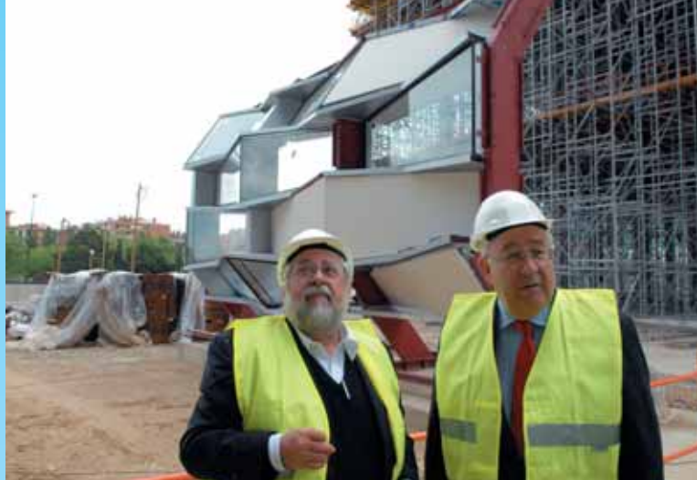
El vicepresidente del Gobierno, José Ángel Biel, y el arquitecto Daniel Olano, en visita a las obras del Pabellón de Aragón.
