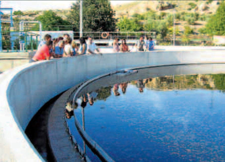
Potabilizadora de Alcubierre.
