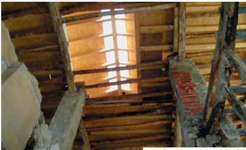
Techumbre en obras de la Casa Balle
