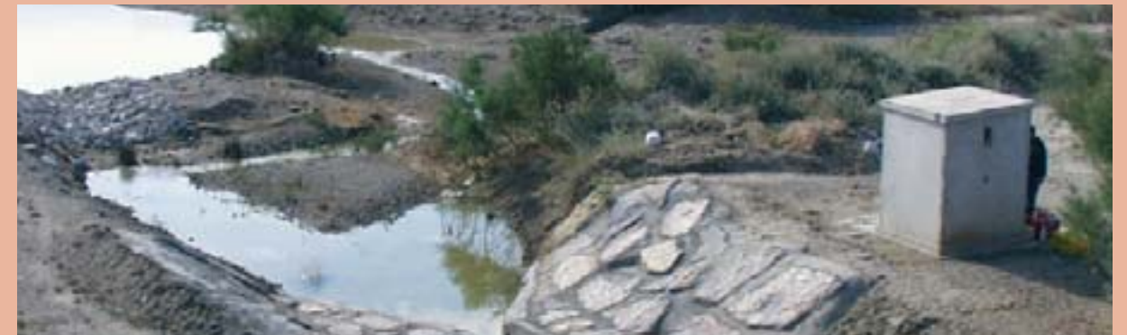
Fig. 3. Estación de control de la cantidad y calidad del agua circulante por el barranco de Lerma.
