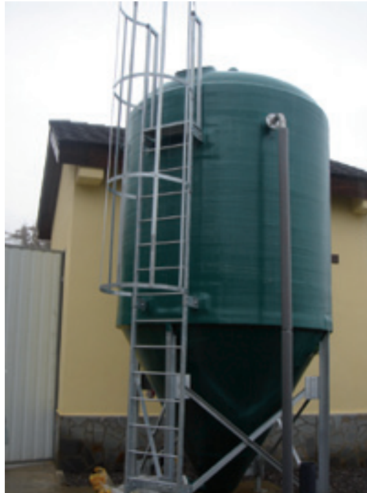
Obras de la depuradora de Yosa de Sobremonte
