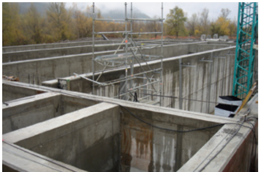
Obras de la depuradora de Biescas
