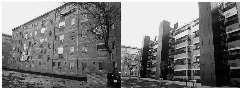
Figura 4. Bloque de viviendas del Grupo Girón antes y después de la rehabilitación
